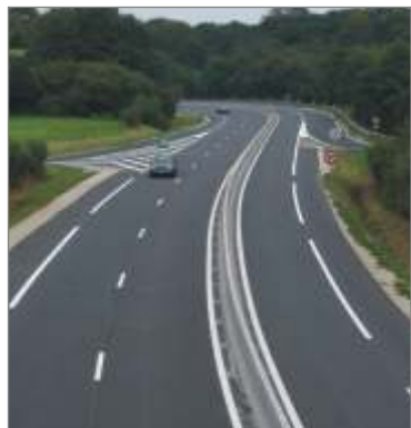
Zone de virages après aménagement
