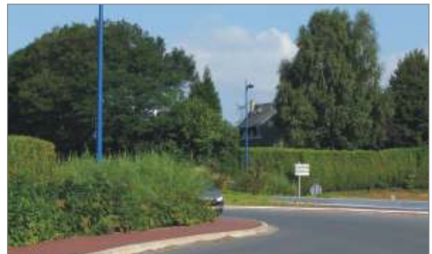
Masque à la visibilité vers Octeville au débouché de la RD231 en venant de Fontaine-la-Mallet
