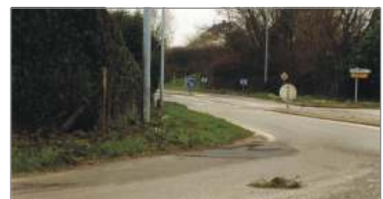
Branche RD231 en venant de Fontaine-la-Mallet Visibilité insuffisante vers Octeville
