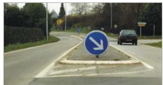
Visibilité insuffisante vers Octeville pour le tourne-à-gauche de Montivilliers vers Fontaine-la-Mallet
